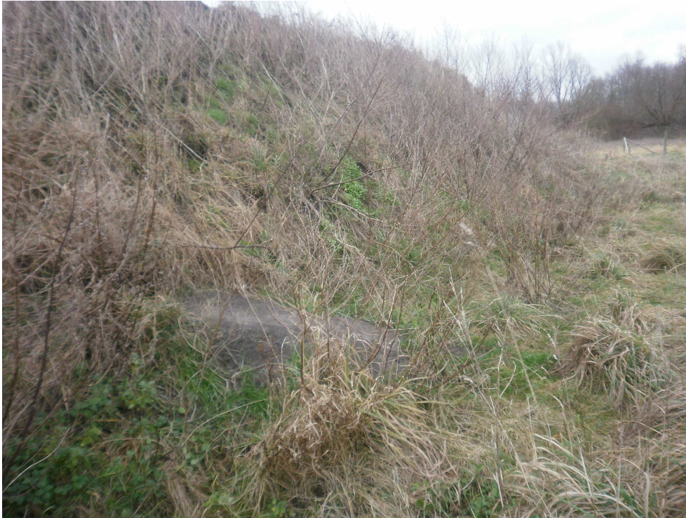
foto 1: Grondlichaam met burcht 124; op de voorgrond is één van de werpheuvels zichtbaar; rechts achter is de beboste vuilstort zichtbaar (opname 04.01.2012)
