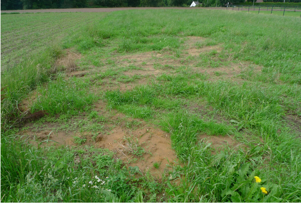
foto 3: Vluchtpijp, met sporen van egalisatie (zie zand op het grasland)
