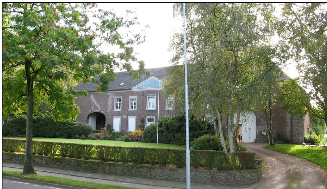
Afbeelding 16. Historische bebouwing van het agrarisch bedrijf Vaesrade 62-64
