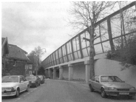
Geluidswal t.p.v. Nuinhofwijk (Spoorstraat)
