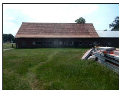
Figuur 8. Noordzijde onderzoekslocatie met achterzijde schuur.
