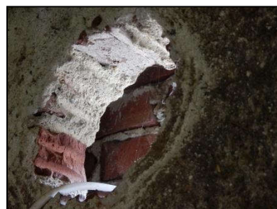
Figuur 14. Spouwmuur aanwezig in de schuur.
