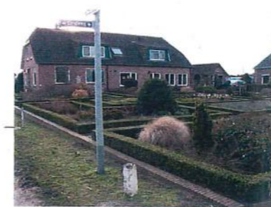
FOTO 6: voorgevel boerderij Eindweg 17 - Veerstraat 2
