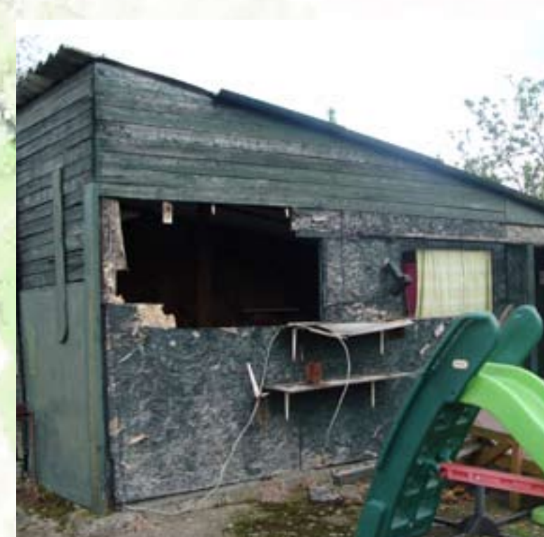
Te verwijderen/ herbouwen schuur
