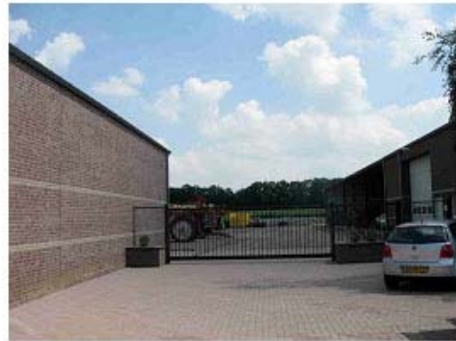
Zicht op binnenterrein
