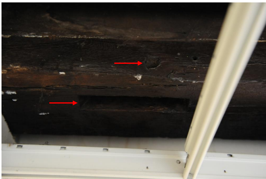
Afb. 17: inkeping voor schoor of korbeel en gat voor toognagel
