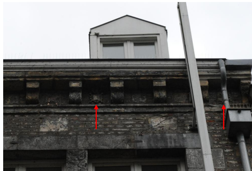
Afb. 12: bakgoot met consoles en twee wapenstenen
