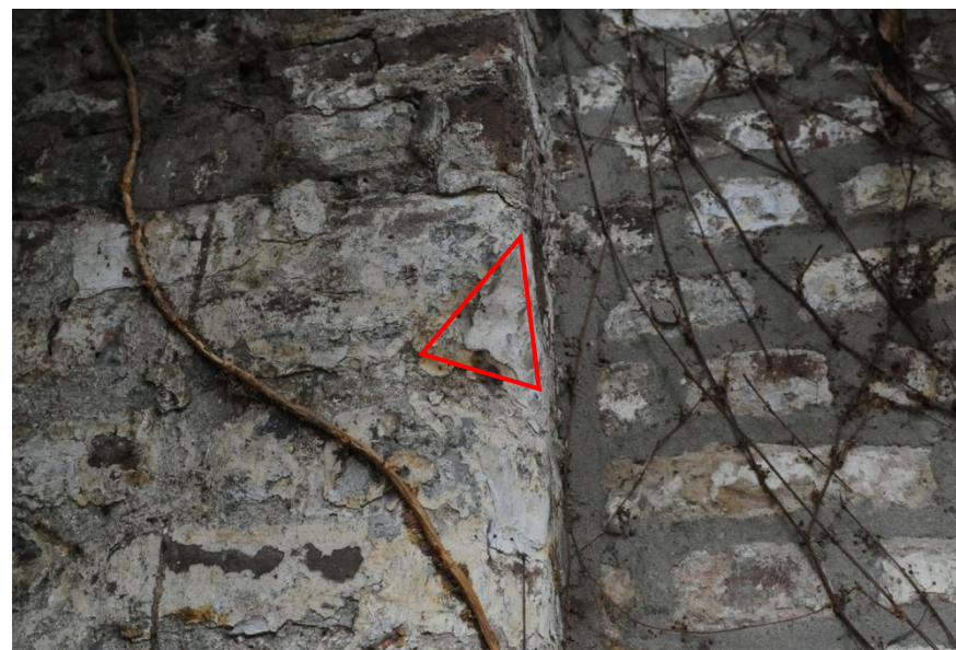
Afb. 18: sprong in metselwerk
