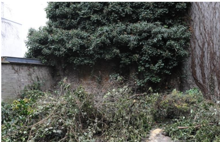
Afb. 19: muur tegen achterzijde perceel nr.50
