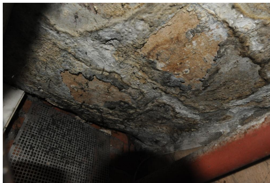
Afb. 14: mergelstenen in gewelf technische ruimte onder nr. 51
