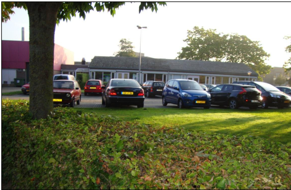
Op de achtergrond de zuidgevel van de bestaande bebouwing en op de voorgrond de bestaande parkeerplaatsen
