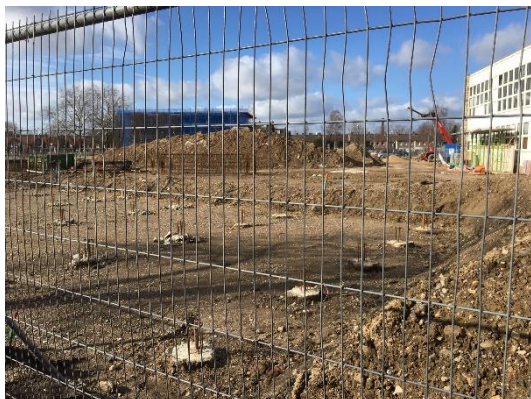
Zicht op nieuwbouw vanaf Voltastraat
