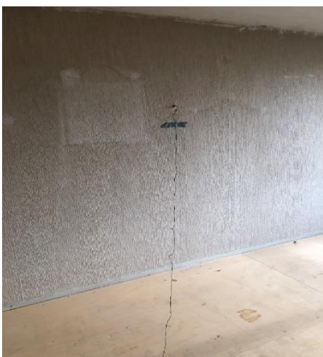
Trillingmeetpunt 3, lange binnenwand
