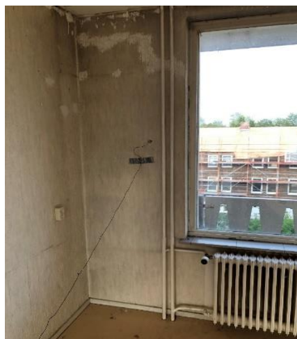
Trillingmeetpunt 6, penant achtergevel
