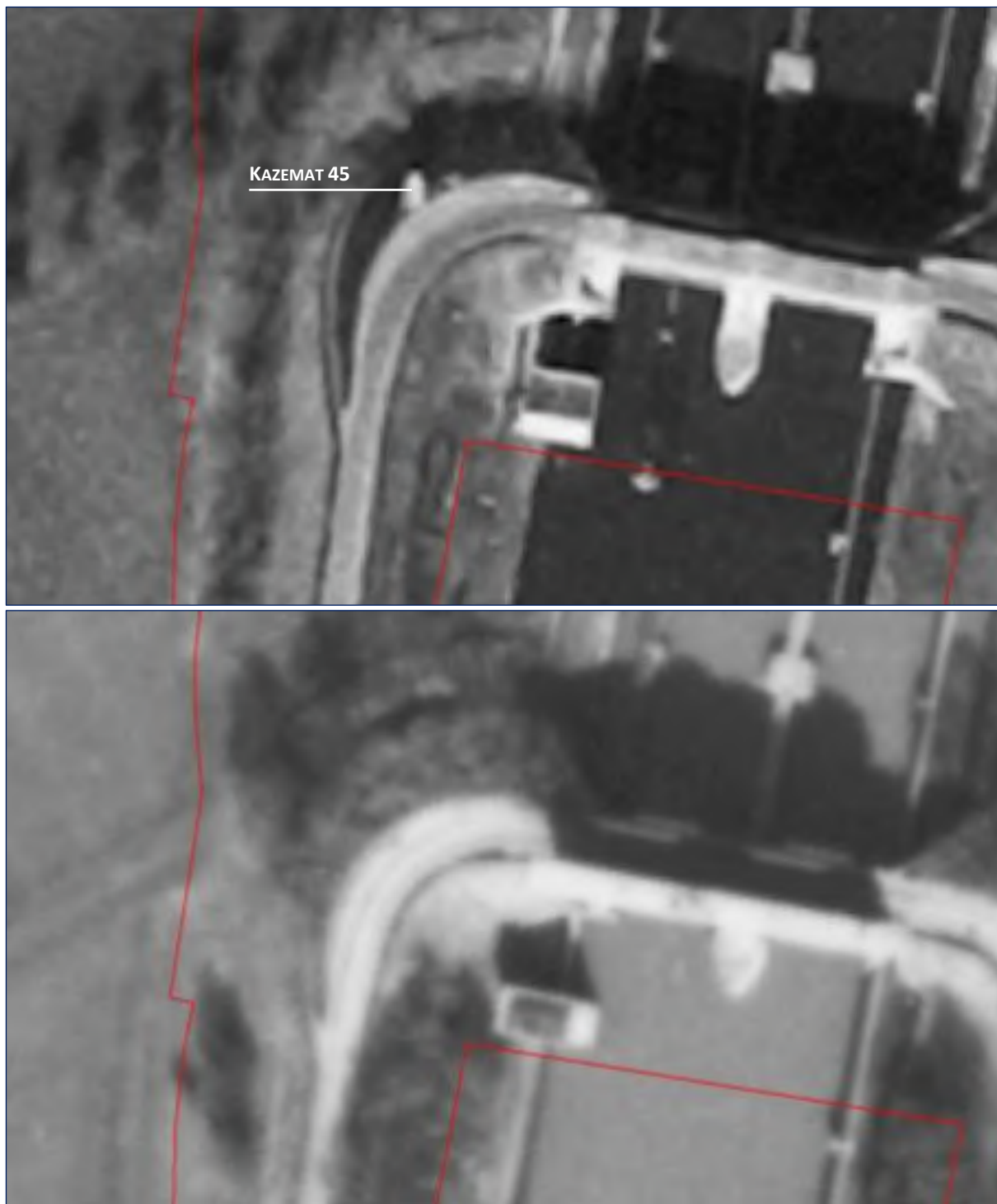
Figuur 13: Luchtopnamen van de sluis te Limmel uit 1965 (foto boven) en 1989 (foto onder). Doordat de foto's onder een verschillende hoek zijn genomen, treedt er een enigszins vertekend beeld op. Op beide opnamen is het nieuwe gebouw ten zuiden van de sluis (zie figuur 12 ) aanwezig. Op de opname uit 1965 is kazemat 45 nog aanwezig, op de volgende foto is deze verdwenen.
