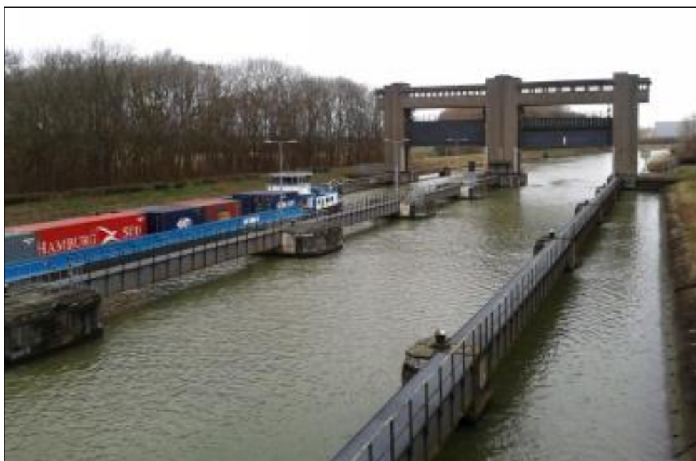
Figuur 1.1 De keerschutsluis bij Limmel vanuit het zuiden (foto Dirk Kruijt).
