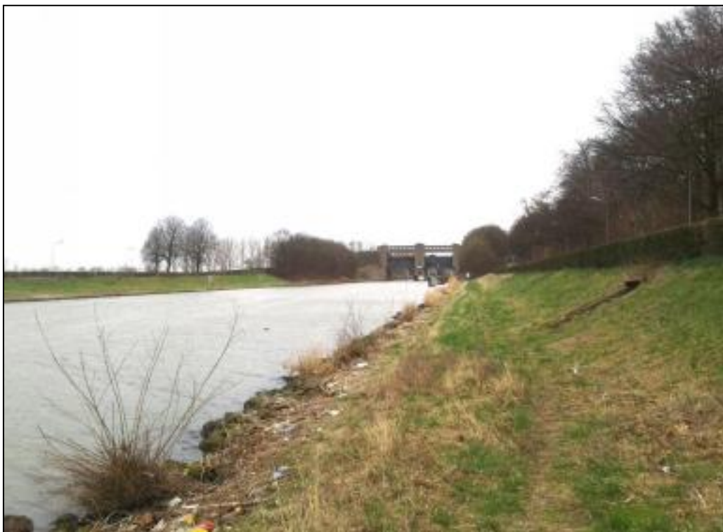
Figuur 3.3 Oevers van het Julianakanaal ter hoogte van de sluis.
