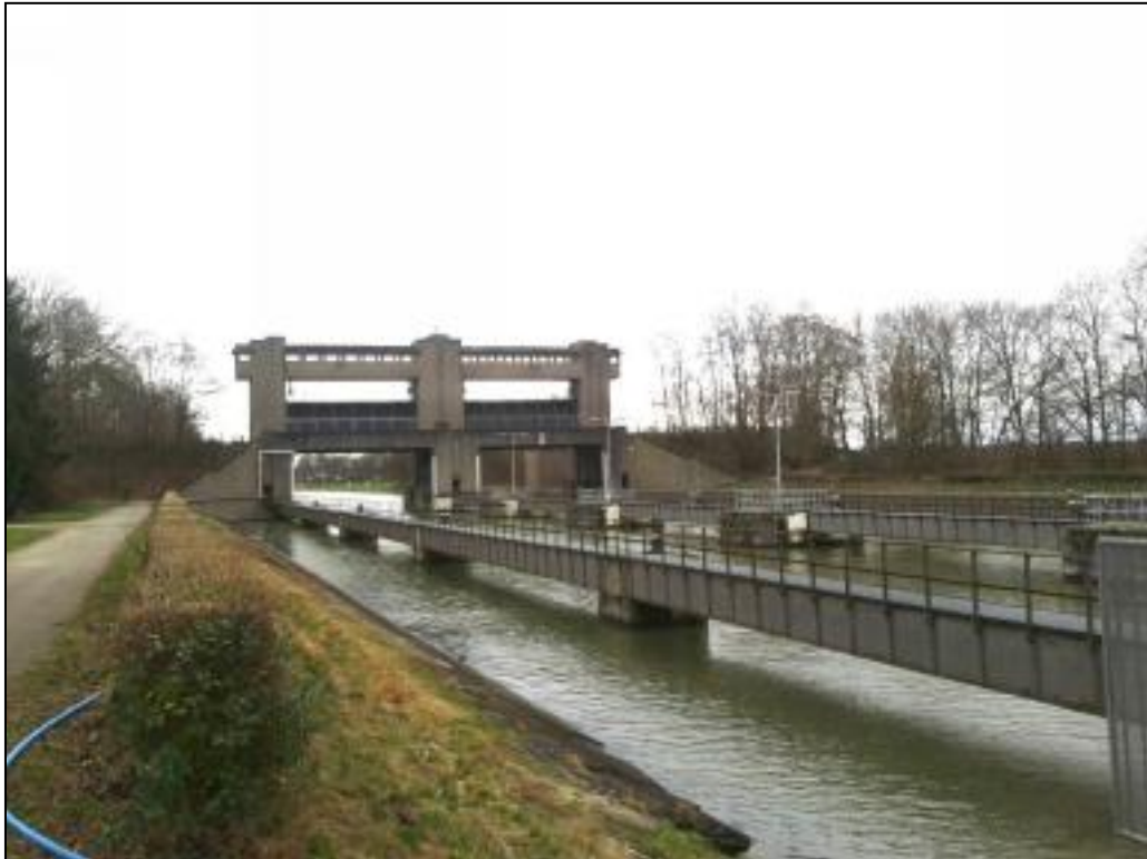
Figuur 3.2 De bestaande sluis.
