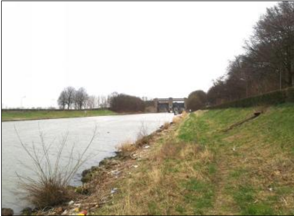
Figuur 2.3 Oevers van het kanaal ter hoogte van de sluis (foto Dirk Kruijt).
