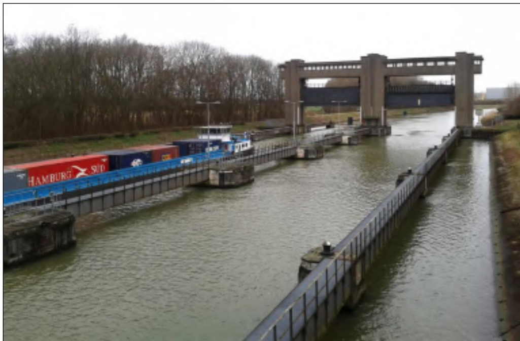
Figuur 1.2 De keerschutsluis bij Limmel vanuit het zuiden (foto Dirk Kruijt).
