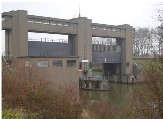
Aanzicht sluis (zuidzijde)
