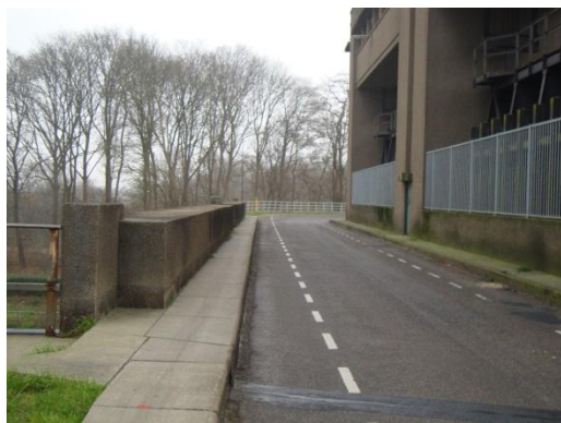
Brug over bovenhoofd sluis
