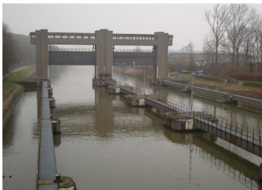
Overzichtsfoto keerschutsluis Limmel
