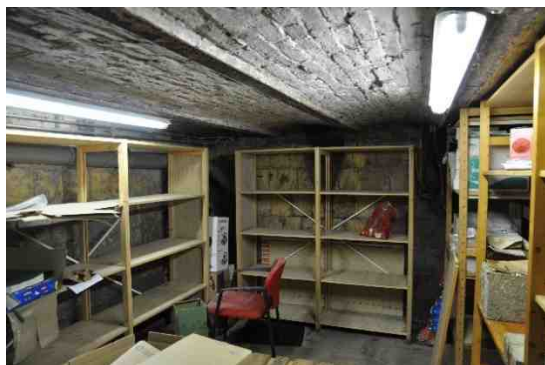
9 de kelder onder het zuidelijke deel van het pand
