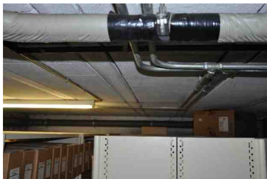
10 vernieuwd betondek boven de noordelijke kelder
