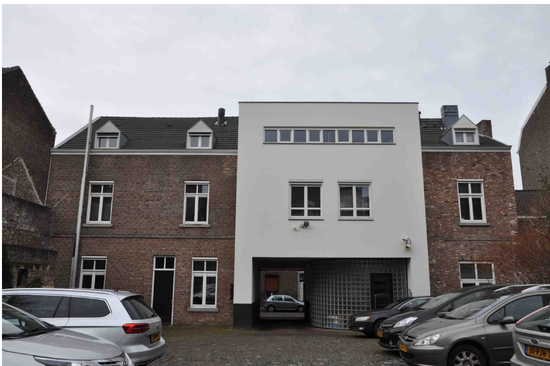
8 de achtergevel aan de binnenplaats met de moderne geveluitbouw in het midden
