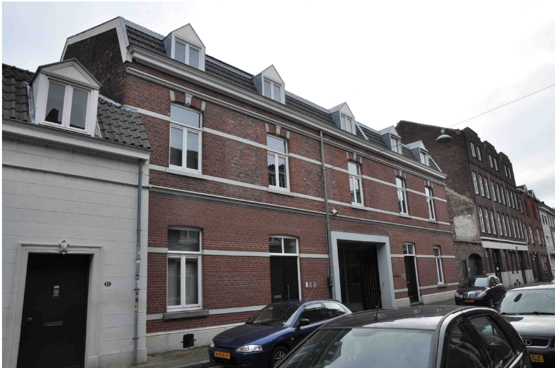
7 de voorgevel aan de Batterijstraat
