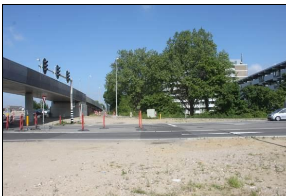
figuur 3.6. Foto van kruising Viaductweg, Meersenerweg.
