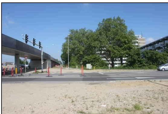
figuur 3.6. Foto van kruising Viaductweg, Meersenerweg.
