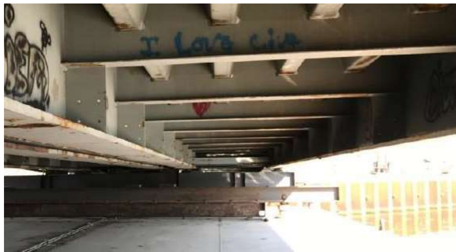
hergebruik brug Vlissingen (liggers, hekwerk niet)
