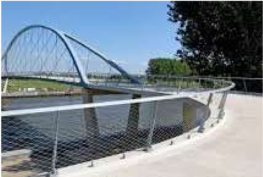
RVS gaas, Carl - Stalh X-tend R2mm, maaswijdte 80mm gemeente Maastricht
