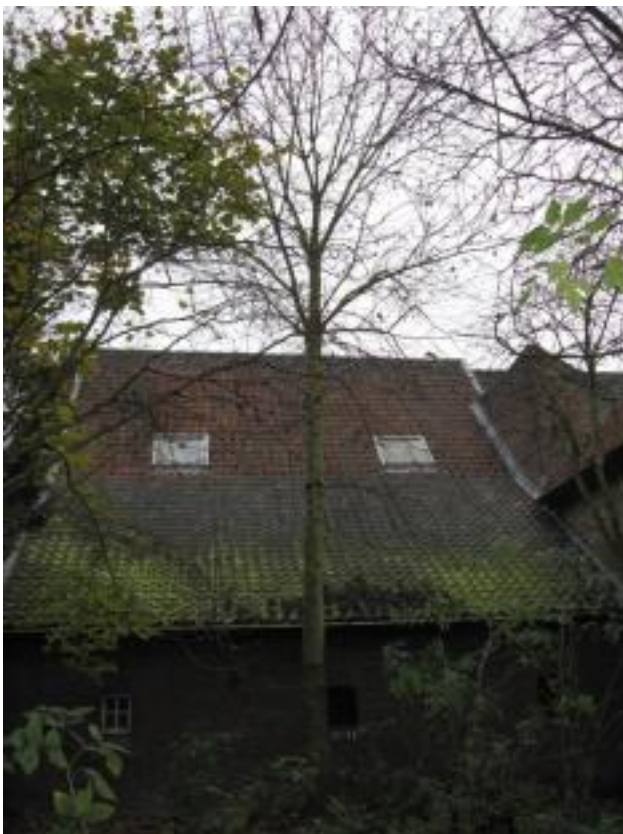
Foto 4; boom 2 tegen de gevel van de achterbouw
