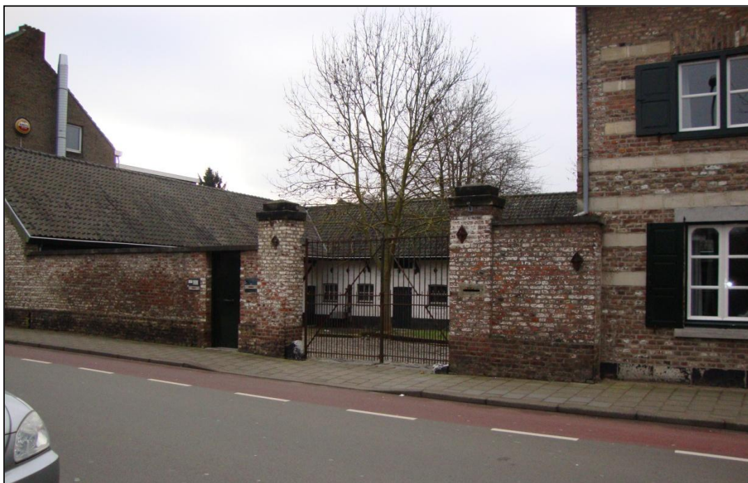
De projectlocatie (noordzijde), gezien vanaf de overzijde van de Wethouder van Caldenborghlaan
