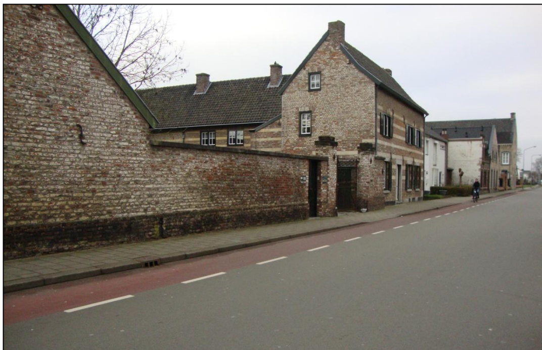
De projectlocatie (noordoostzijde), gezien vanaf de overzijde van de Wethouder van Caldenborghlaan
