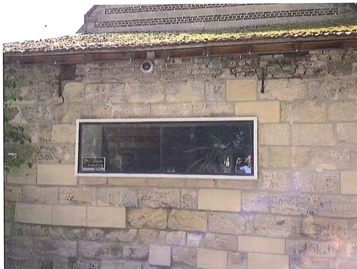
foto aan te passen kozijn (hierin wordt een middenstijl toegevoegd)
