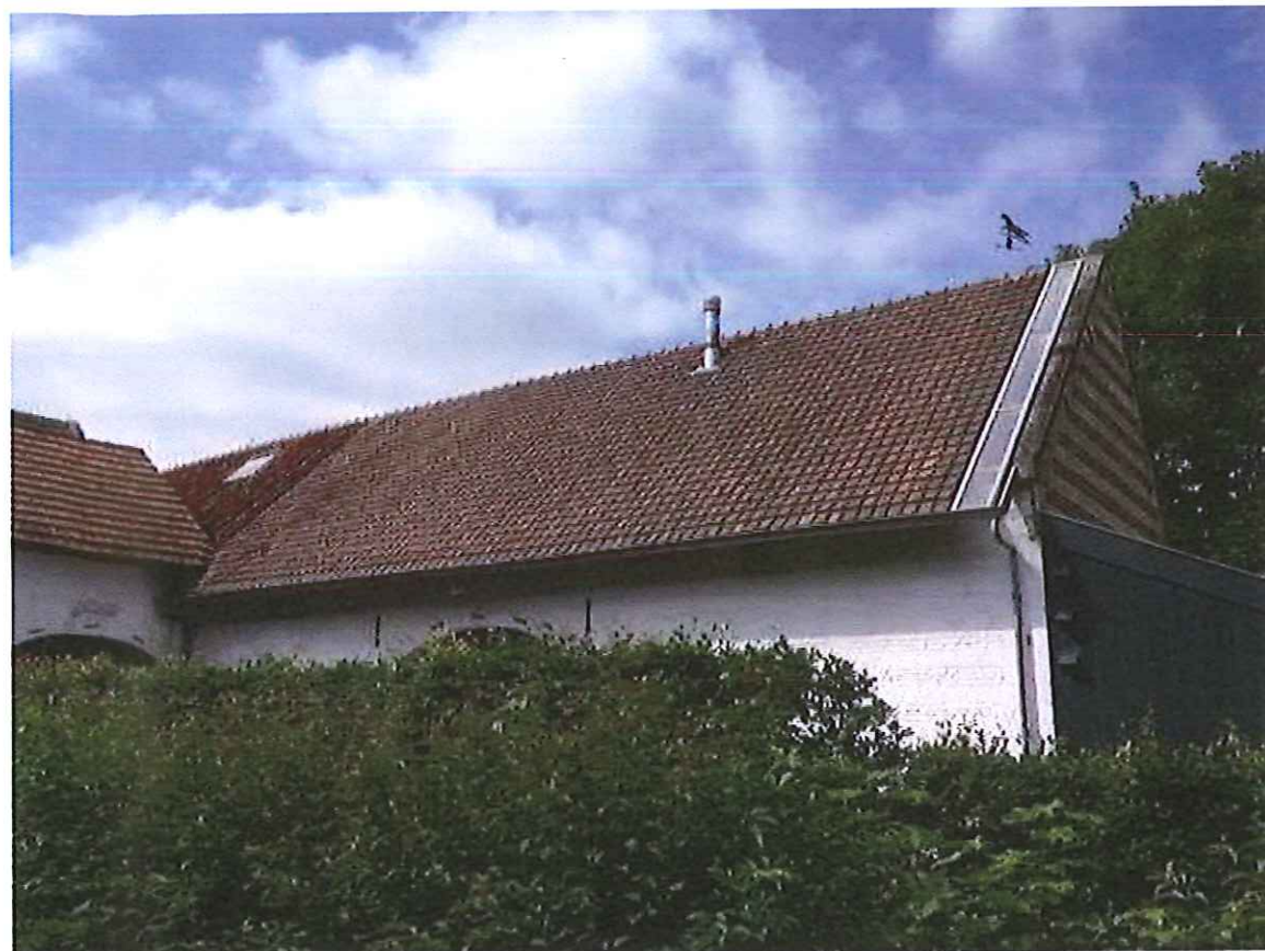
foto dakvlak achtergevel (hierin worden 2 veluxramen cf. bestaand toegevoegd)
