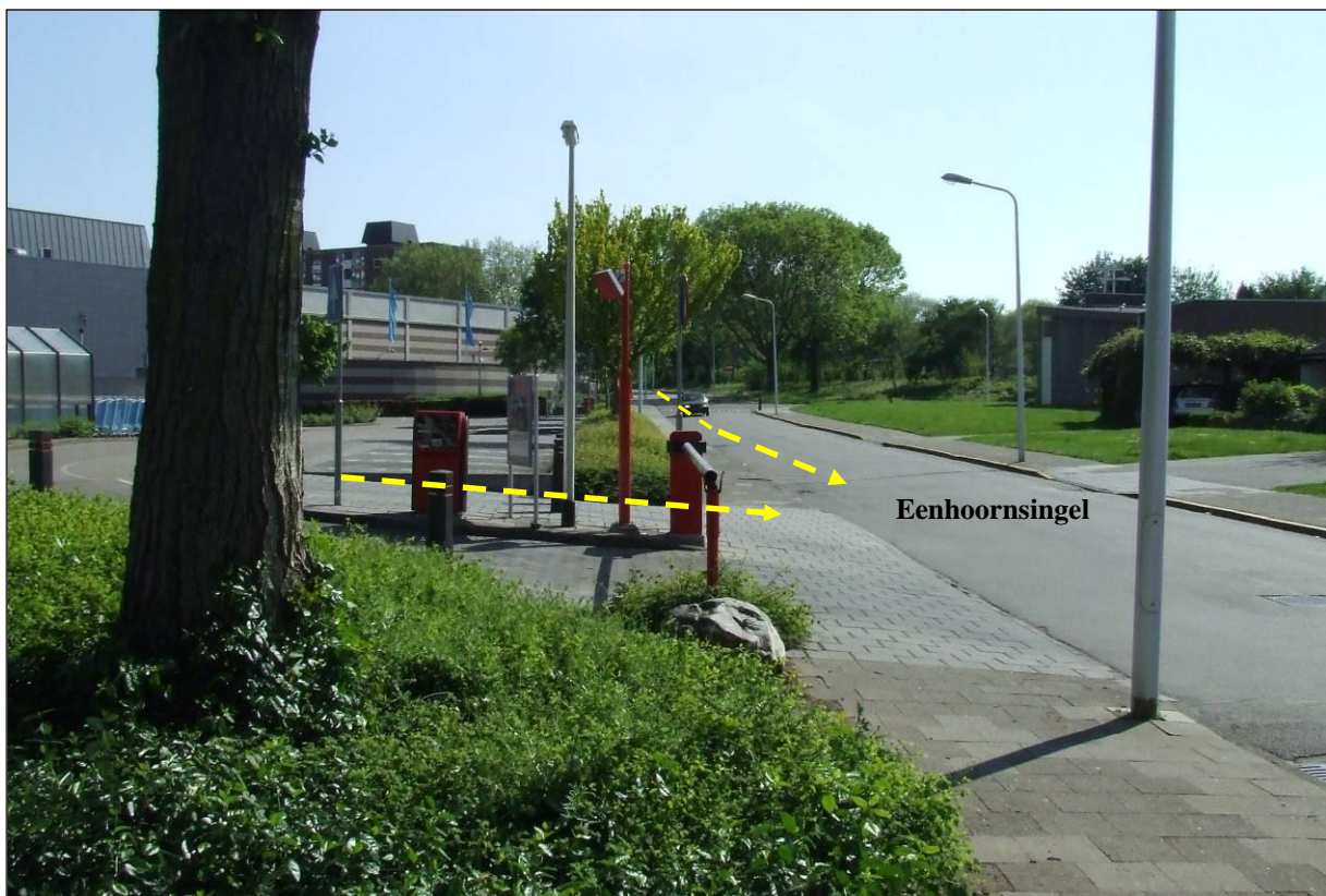
Figuur 20: Zicht het westelijke deel van het plangebied langs de Eenhoornsingel. Het plangebied ligt duidelijk hoger dan het straatniveau, waarschijnlijk door ophoging tijdens de bouwphase in 1971.
