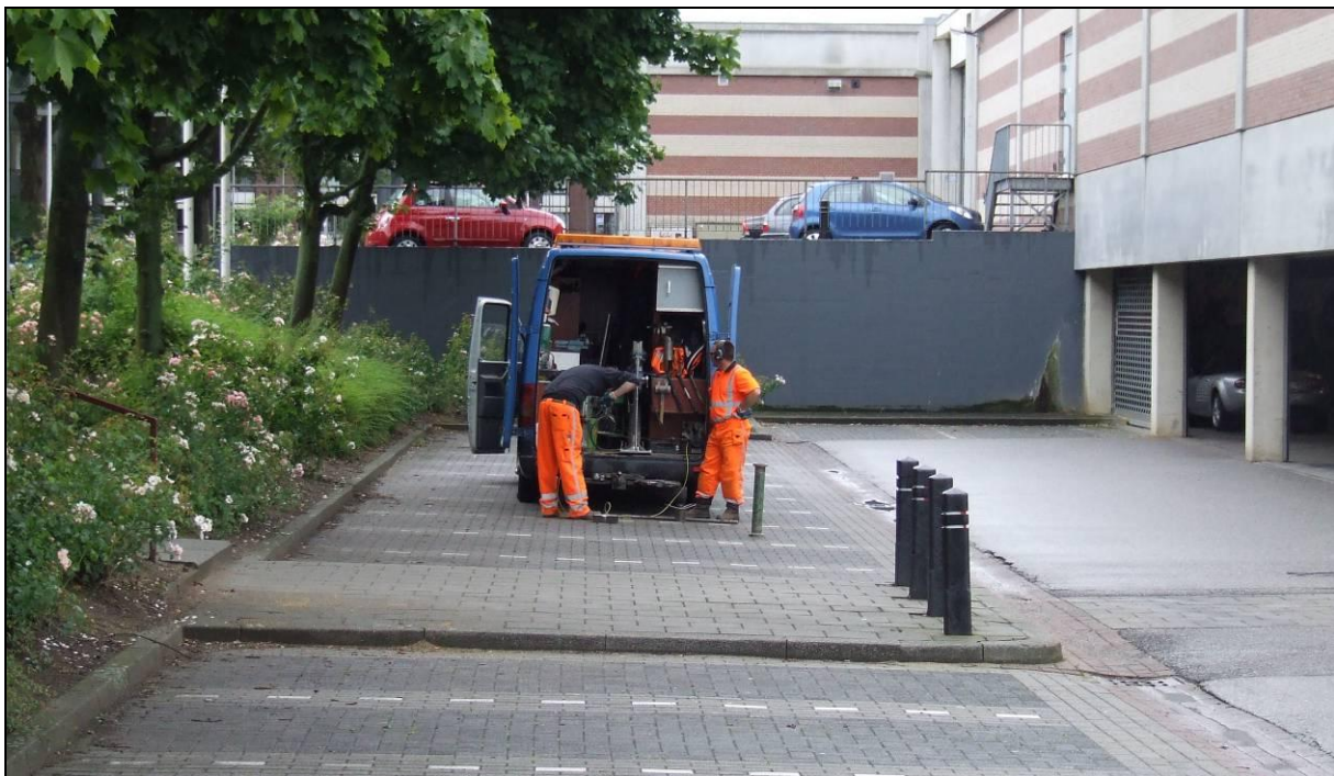
Figuur 25: Mechanische ramgutsboring ter plaatse van boorlocatie 1.
