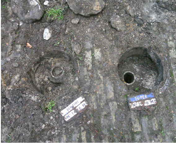
Foto 1. Vulpunten benzine tanks (deellocatie 5)
