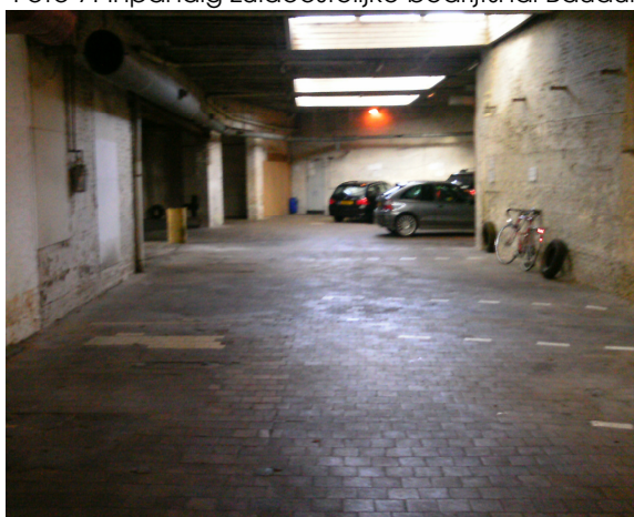
Foto 7. Inpandig zuidoostelijke bedrijshal Bauduin
