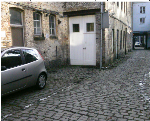
Foto 5. T.p.v. HBO-tank in de oprit (deellocatie 1)
