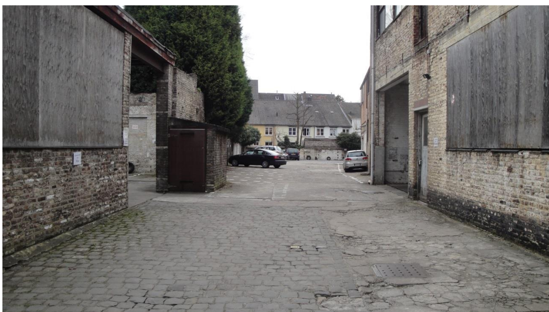
Figuur 6: Binnenterrein aan de zuidkant. Het hemelwater wordt via kolken afgevoerd.
