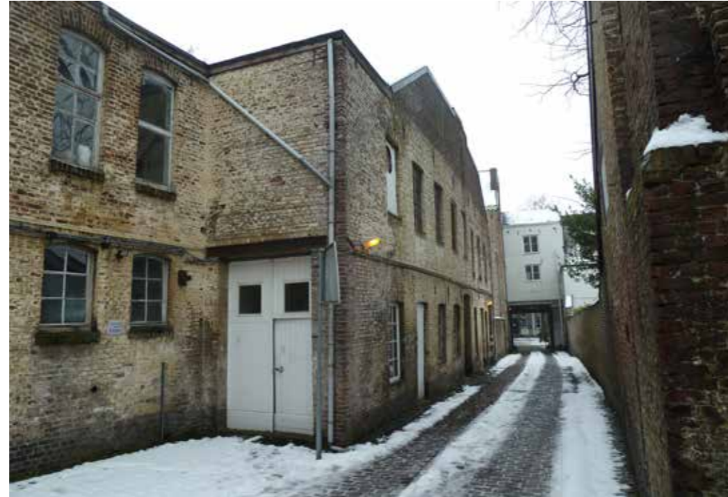
2. Voormalig magazijn wordt gesloopt
