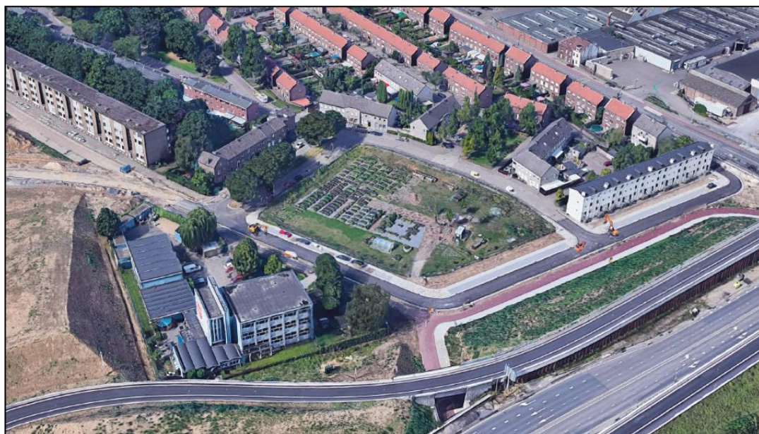
Perspectieffoto recente situatie voor amovering tijdelijk volkstuintencomplex
