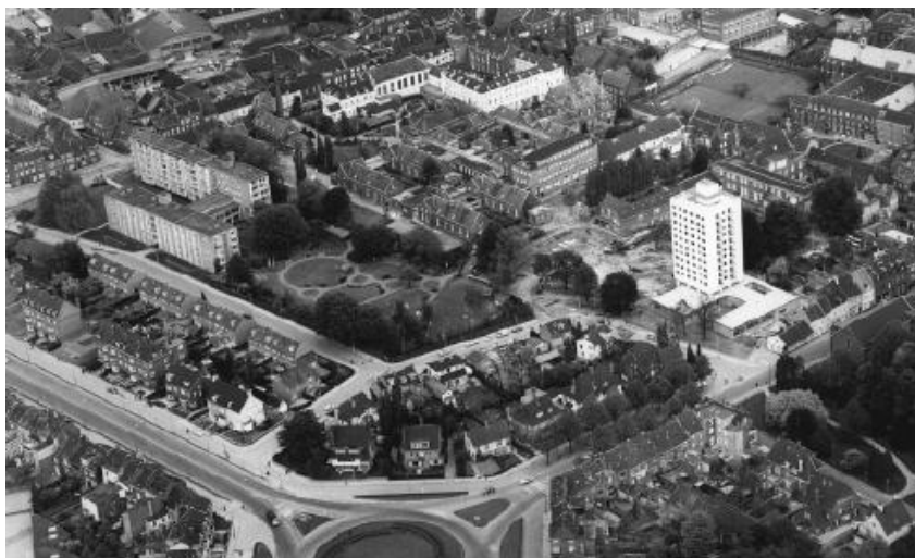
Luchtfoto uit 1962, korte tijd na gereedkomen van de Polvertorenflat
