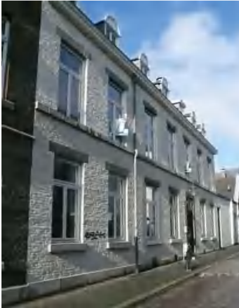
Abtstraat 4: Monumentaal woonhuis naast de affuitloods
