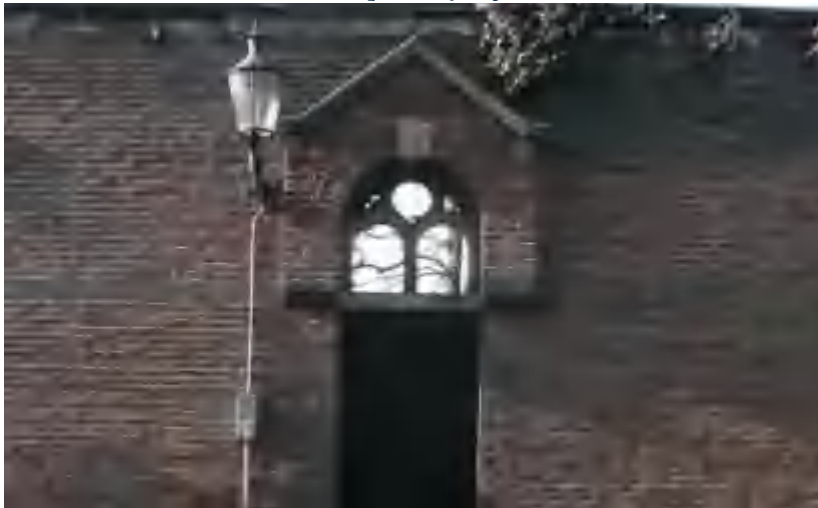
Muurwerk tussen de panden Abtstraat 8 en 16, foto 2009
