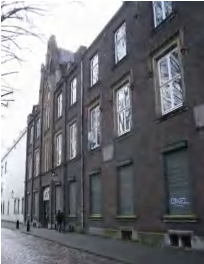
Administratiekantoor van het Burgerlijk Armbestuur: gevel aan de Abtstraat, foto 2009
