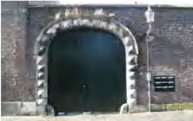
Abtstraat tussen nrs. 8 en 16: monumentale poortomlijsting
