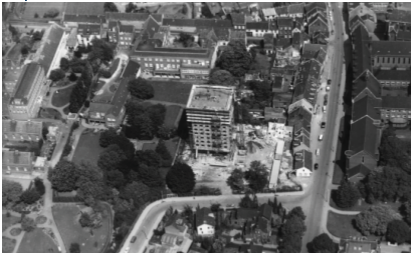
Luchtfoto van het Klevarierrein in 1961 tijdens de bouw van de Polvertorenflat
