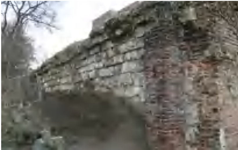
Schoormuur gezien vanuit het zuidwesten, foto 2009
