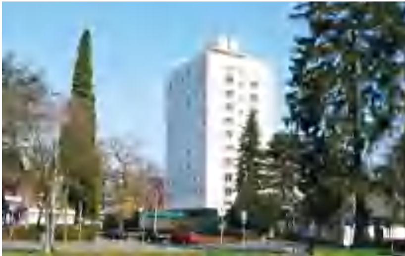
Verpleegstersflat aan de Polvertorenstraat, foto 2009
