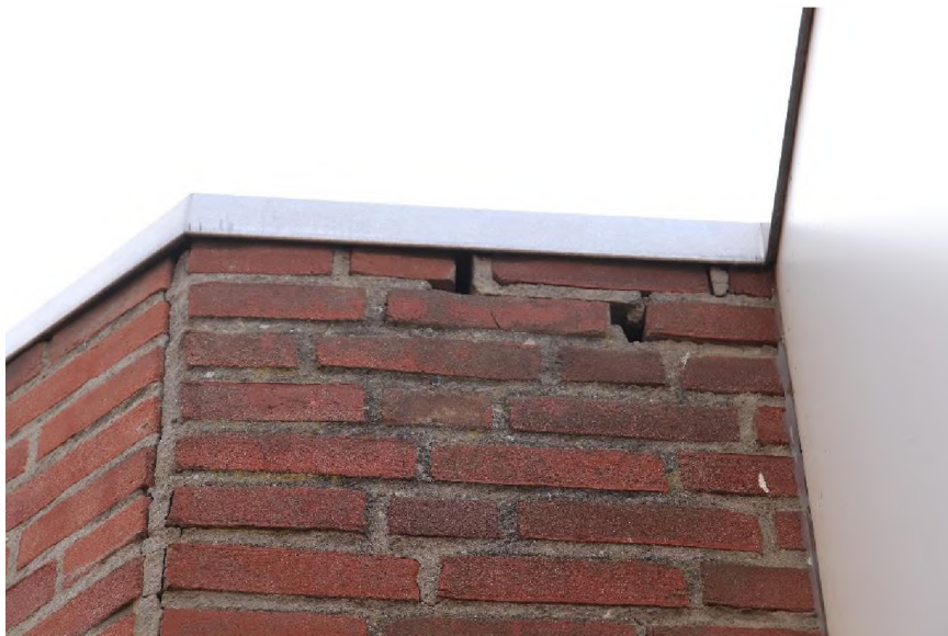
Foto 1: openingen die toegang geven tot de achterliggende spouw, bieden in potentie ruimte aan vleermuizen
