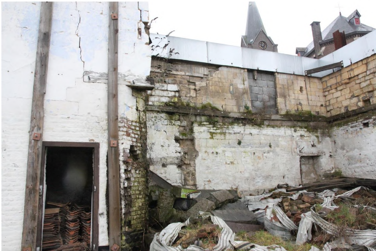
Foto 2: Mergelmuur met opslaghokken in de zuidwesthoek van de ingreeplocatie
