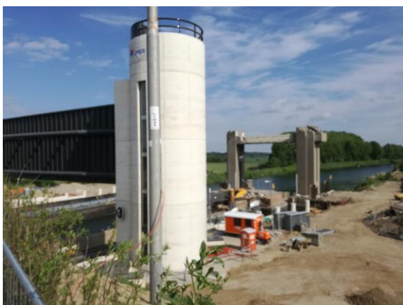
Nieuwe kersluis Julianakanaal (rechts sloop oude sluis)
