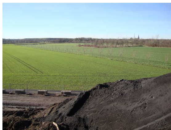
Zicht op het westen vanuit de Keersluis
