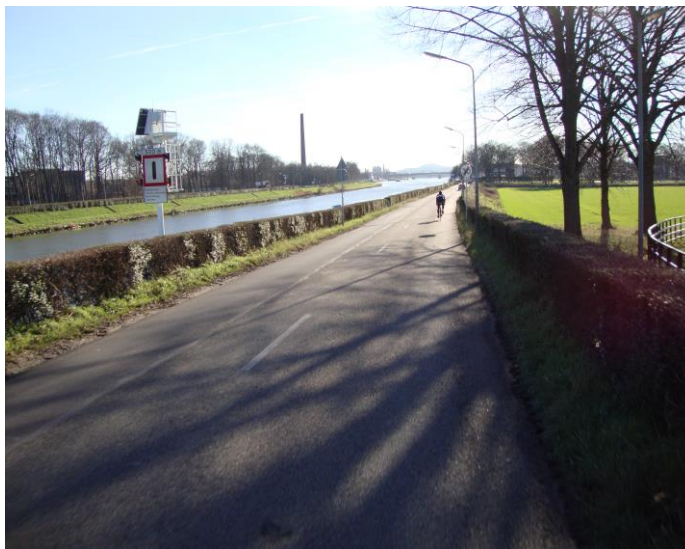
Zicht op de Sluisdijk richting het noordwesten
