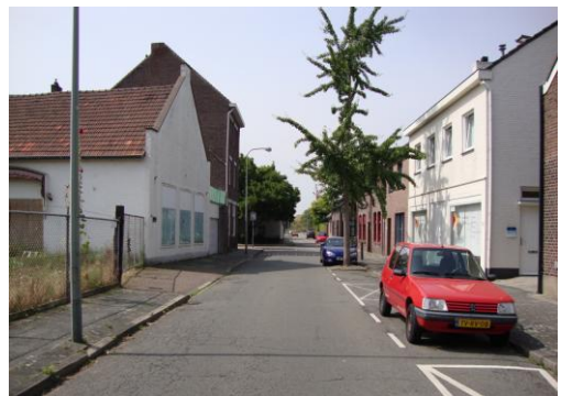
Bedrijfsbebouwing, gezien vanuit de Sint Josephstraat
