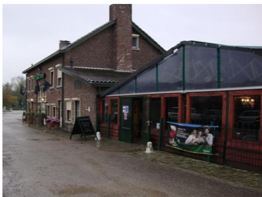
Tijdelijke voorziening voorzijde (Slakweg)
