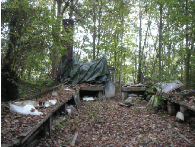
Afbeelding 7: Gedeeltelijk afgebroken gebouw in het bosje.
