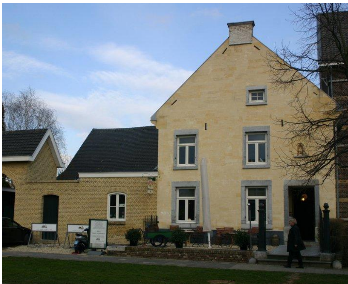
Figuur 12: pand Ambyerstraat-Noord 74
