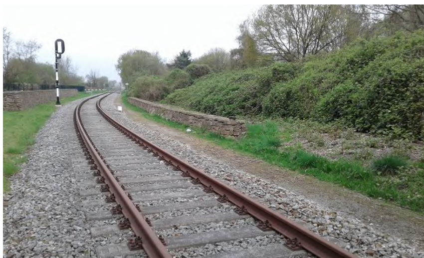
Tracé nabij brug Fort Willemweg
