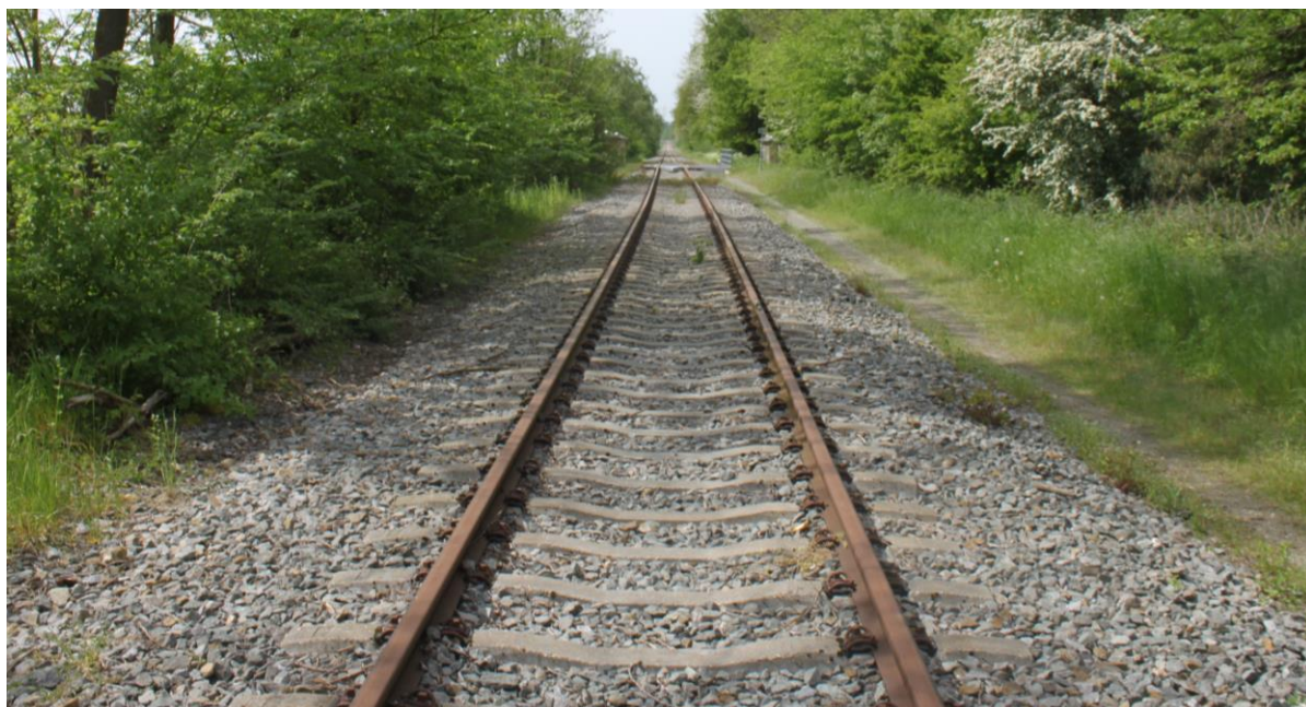
Foto 6: Beeld op het spoorbruggetje over de Brusselseweg. De das loopt aan weerszijden van het spoor van en naar de burchtlocatie en het Zouwdal (foerageergebied) en de groeve van Klinkers (oostkant spoor).
