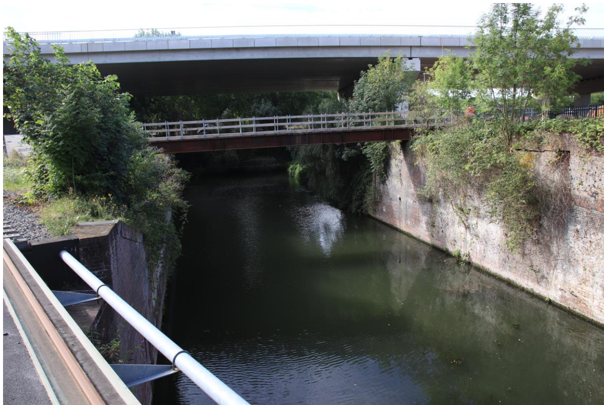
Foto 5: Beeld vanaf de spoorbrug over het Bassin richting zuiden (centrum), met daarboven de nieuwe Noorderbrug. Vleermuizen, zo blijkt uit het onderzoek, vliegen onder het brugelement van het spoor én de nieuwe Noorderbrug, omdat dit geheel onverlicht is.
