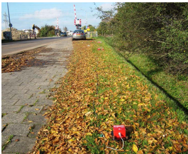
Figuur 4, Meetopstelling Limmelderweg (meting trillingen spoor).
