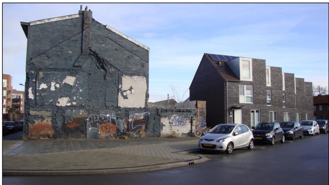
De linker zijgevel van de woning Heugemerweg 105 en de nieuwbouwwoningen Heugemerweg 115 t/m 123
