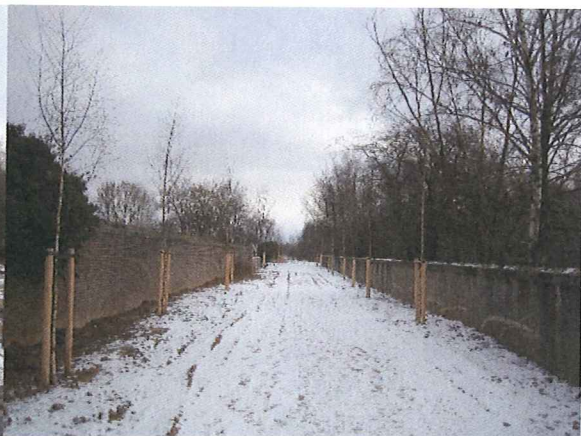
Figuur 5: wandel/fietspad tussen muren
