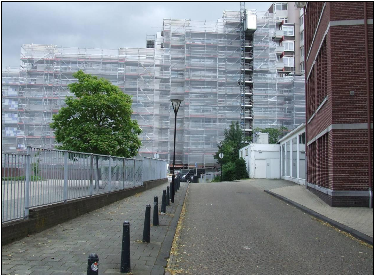
Figuur 16: Het huidige Wijngrachtcomplex gezien vanaf de Doctor Kreijenstraat in noordelijke richting. Ten behoeve van de bouw hiervan is de historische lintbebouwing tussen de Markt en de huidige Wijngrachtstraat gesloopt.
