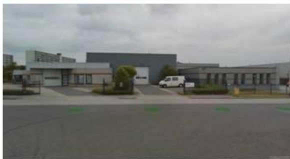
Bedrijfsbebouwing aan de Winckelen, Euregiopark
