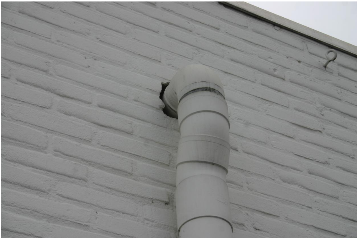
Foto 1. Verschillende openingen voor buizen in de zuidoostgevel van de Lidl geven toegang tot de spouw
