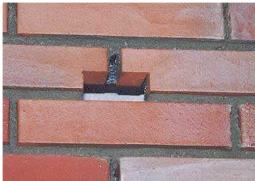
Neststeen na inbouw in bakstenen muur
