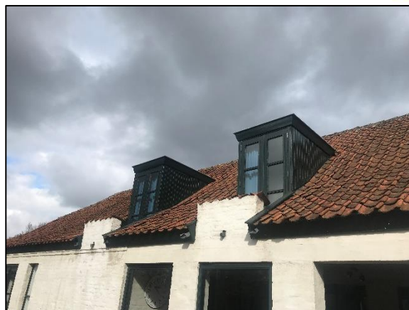
Foto 2. Zuidzijde van de woning
