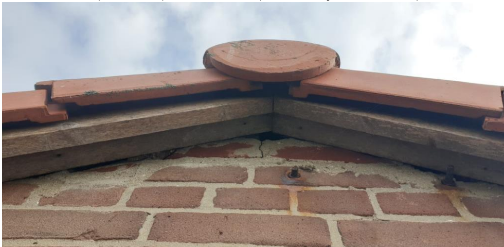
Foto 5. Potentiële verblijfplaatsen voor vleermuizen in de vorm van overhangende dakpannen en openingen naar de spouw (hier bij de nok van het puntdak)
